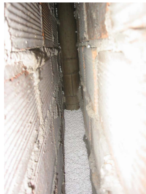
Fig. 10. Detalle del relleno de una cámara de aire con perlas de EPS
