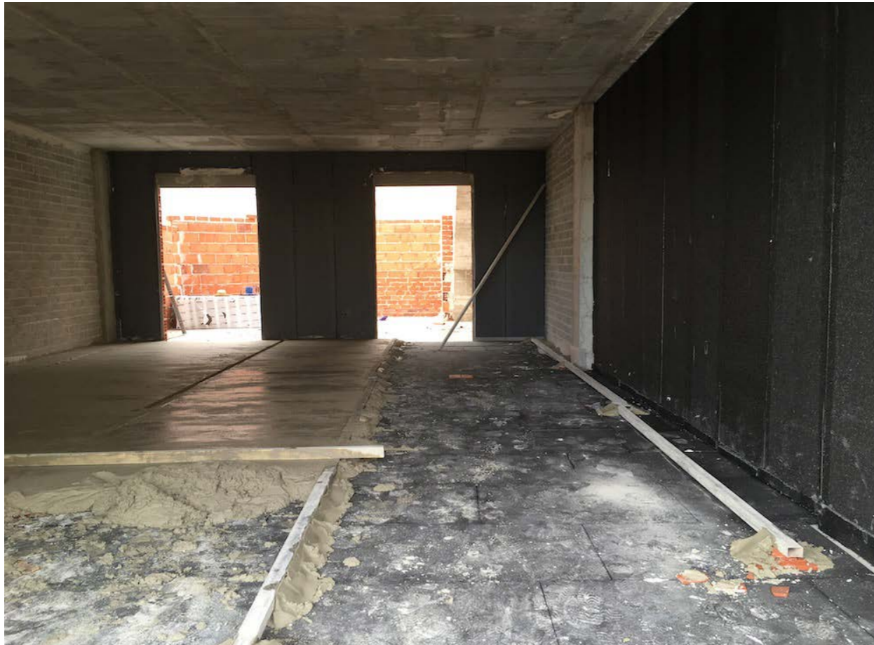
Fig. 16. Instalación de plantas de poliestireno expandido elastificado EPS T en un suelo flotante
