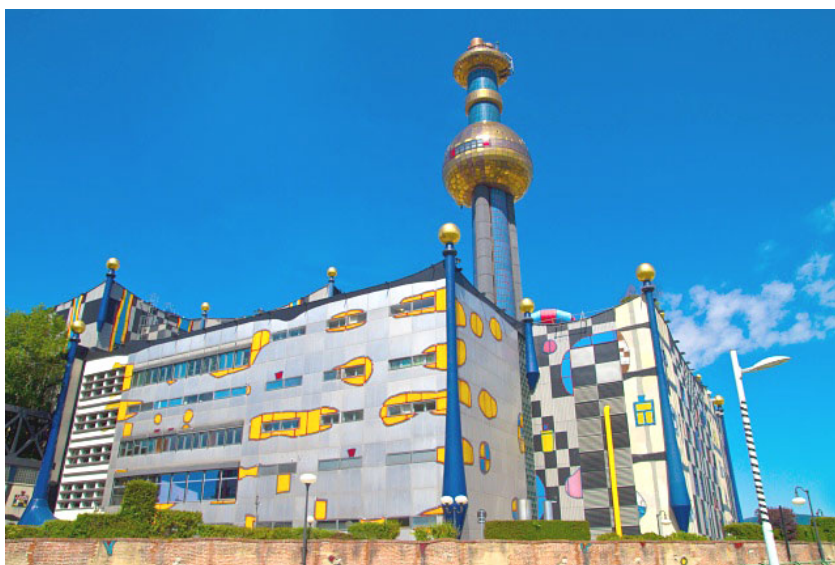
Foto: Planta de incineración de Spittelau (© MA 20 / Steven Duchon)
